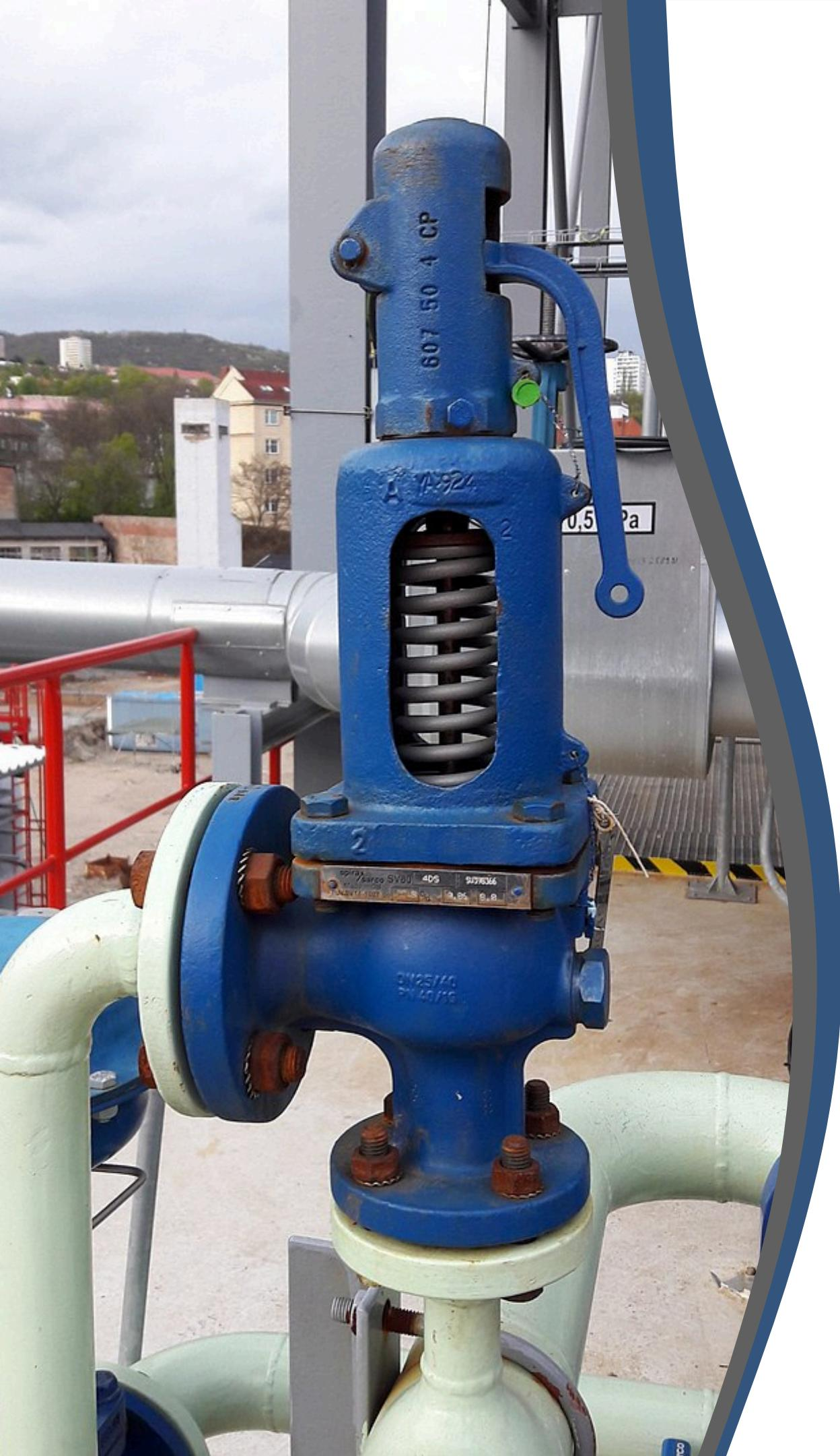
As válvulas de segurança e alívio são dispositivos automáticos de alívio de pressão, sendo obrigatórios em vasos de pressão e caldeiras cuja pressão interna seja superior à pressão atmosférica, evitando as consequências da exposição às condições perigosas de uma possível sobrepressão.
